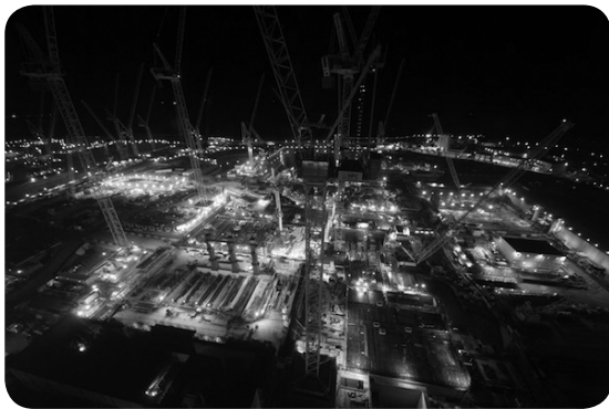
건설 중에 있는 Hinkley Point C 1호기
