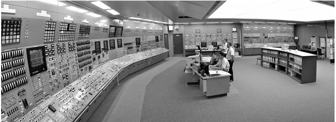
루마니아 체르노보다 가압중수로 원자력발전소 중앙제어실 전경
